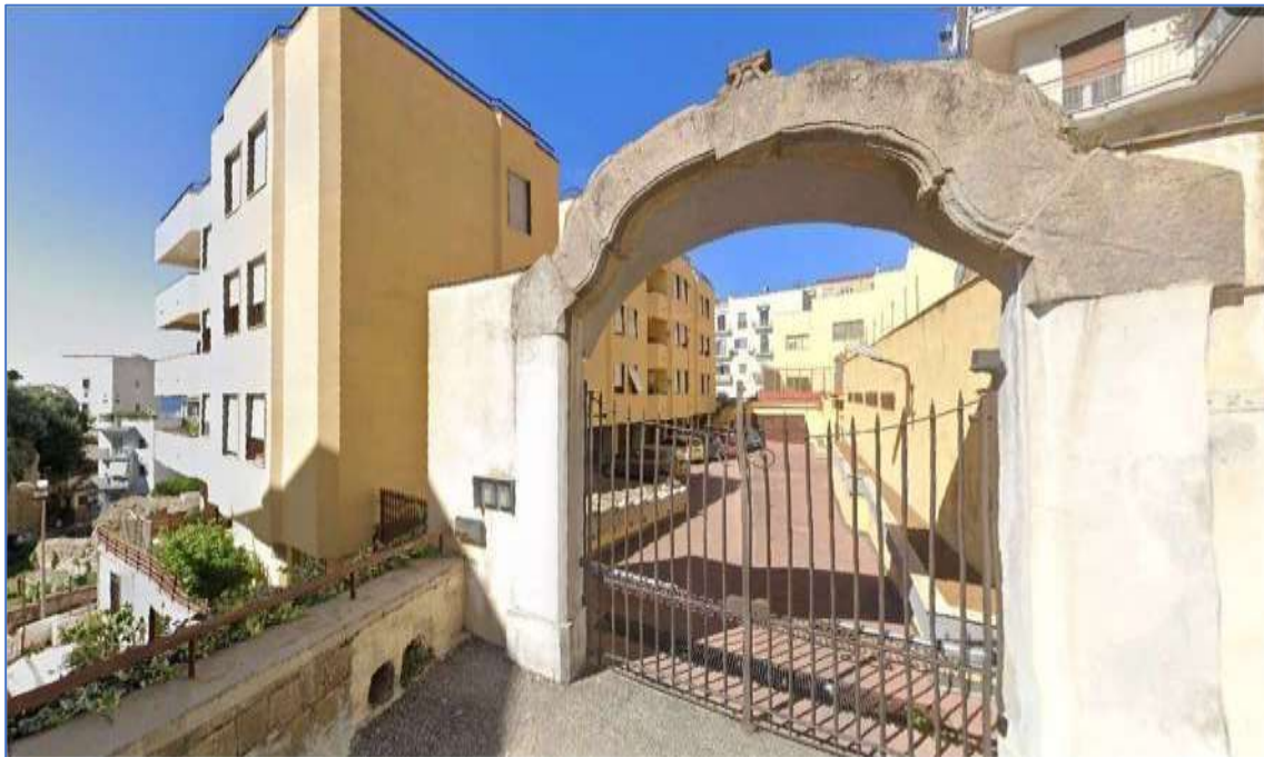
Figura 28. Fabbricato via Ragnisco n. 2/B.
